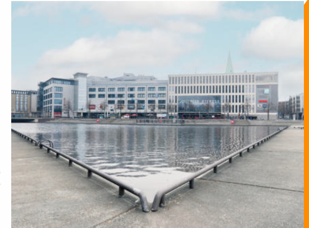
Blick auf das NORDLICHT vom Bootshafen
